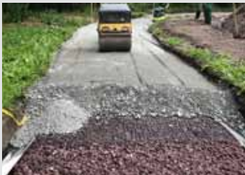
Verbundwirkung zwischen Geogitter und GEOCELL® RED
